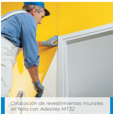
Detalle de colocación
