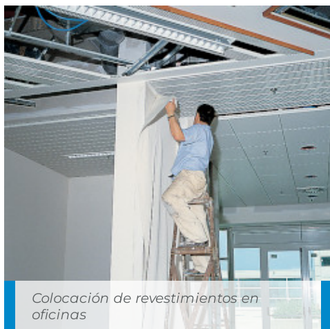
Colocación de revestimientos murales en rollo con Adesilex MT32
