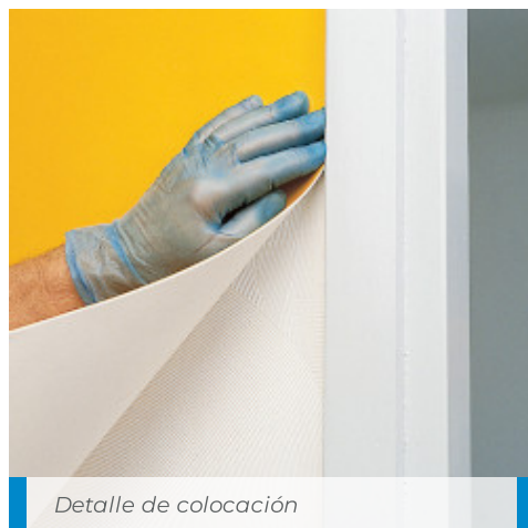
Colocación de revestimientos murales en rollo con Adesilex MT32
